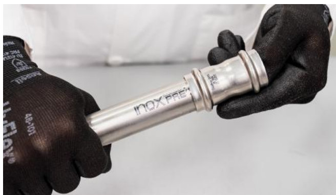
Bild 24 – Einführen des Rohres in den Pressfitting
