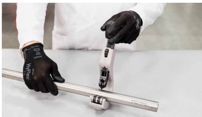
Bild 19 – Ablängen des Leitungsrohres
