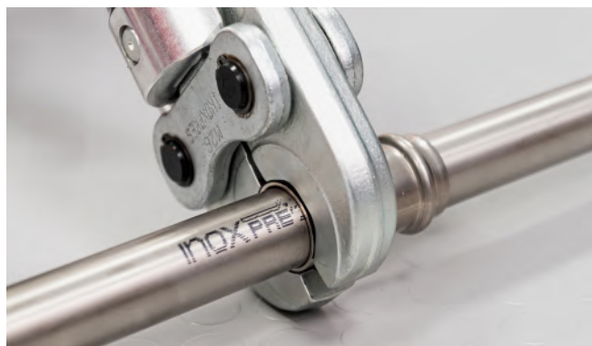
Bild 25 – Herstellen der Pressverbindung
