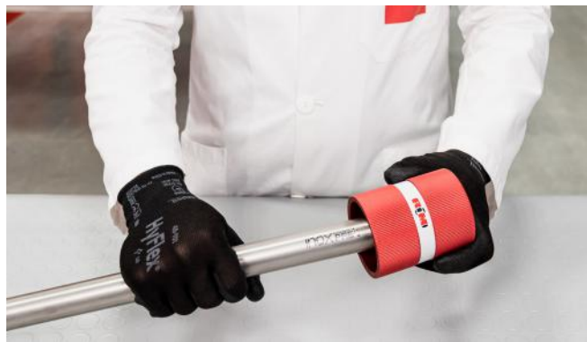
Bild 20 – Entgraten des Leitungsrohres
